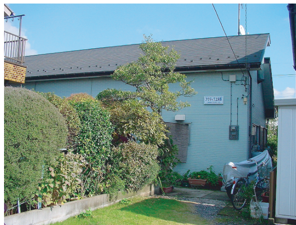
【 建物外観写真 】
